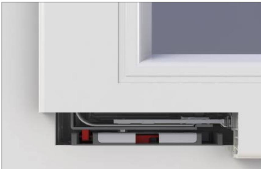
Fenster ist geschlossen und verriegelt. Der 8-Kant-Verschlussbolzen hinterkrallt beim Verschließen das Sicherheitsschließblech und der Tresorbolzen verriegelt mit dem Fensterflügel. Ein Aushebelschutz von bis zu einer  $\frac{1}{2}$  **Tonne** gewährleistet höchste Sicherheit.
